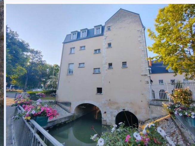
View North from Pont du Puisseaux
