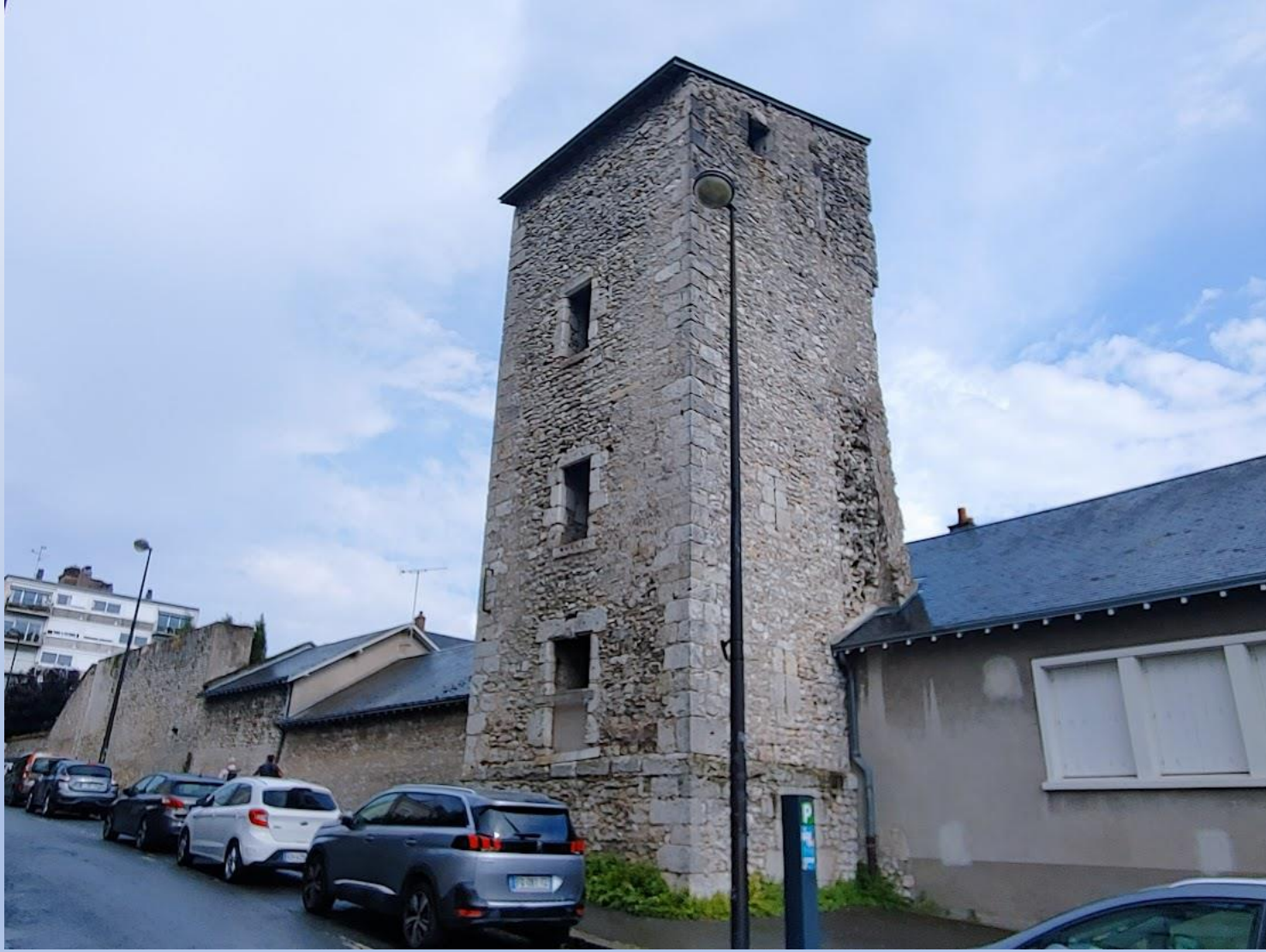
2. Tour Des Cordeliers at Rue Trouessard
